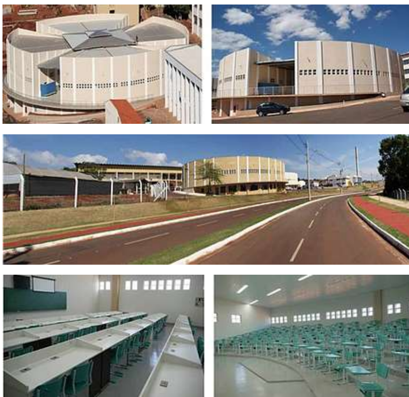
Foto 14. Pavilhão de Salas de Aula
